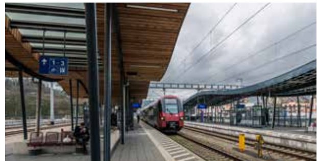
La gare d'Ettelbruck présente le même type de marquise qu'en Gare de Luxembourg.
