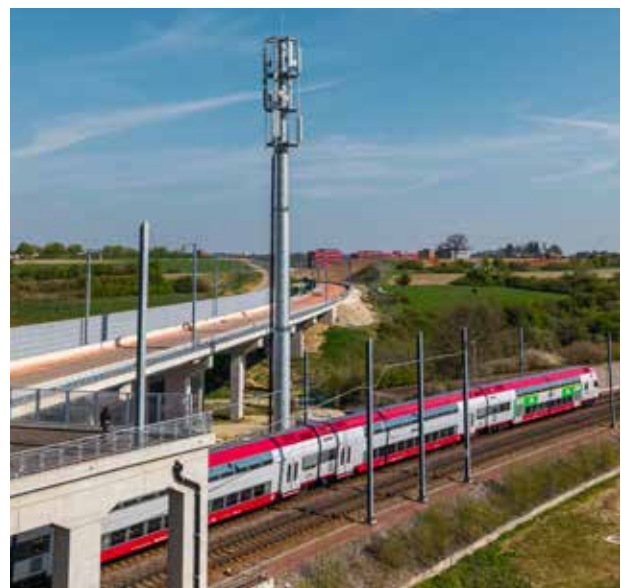
Le pylône a été posé en juillet 2025 aux abords de la nouvelle ligne Luxembourg – Bettembourg.
