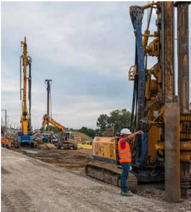
Durant l'été, 200 inclusions rigides ont été placées pour assurer la prise en charge des poids impressionnants des trains qui, à l'avenir, enjambreront en hauteur le tracé de la ABS par l'ouvrage d'art dit « saut de mouton ».
