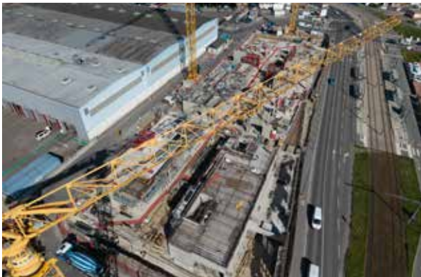
Après la fin des travaux de terrassement en septembre 2025, les travaux de géothermie du nouveau bâtiment administratif à Bonnevoie ont débuté dans la foulée.
