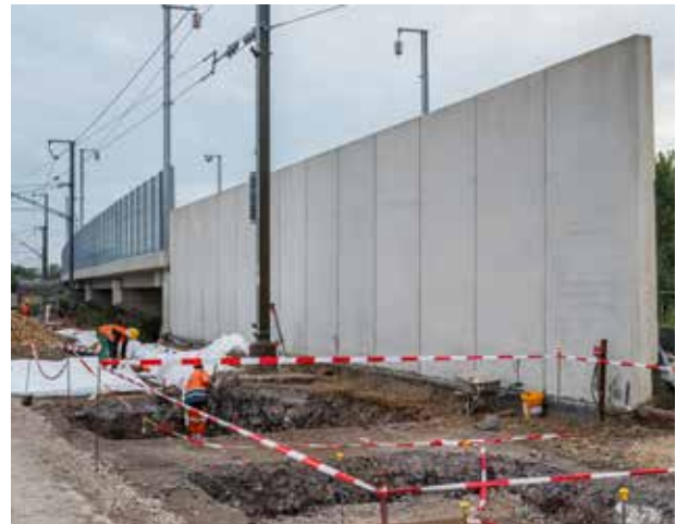
Des murs anti-bruit ont été érigés sur 150 mètres pour limiter les nuisances sonores liées à la circulation ferroviaire.
