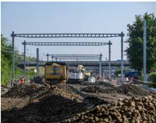
2.650 mètres de voies, 4.420 traverses ou encore 13 aiguillages ont été remplacés durant les opérations d'été.
