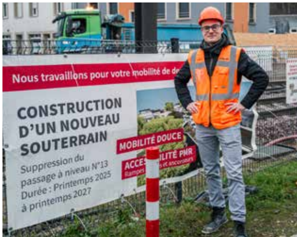
Tim, Chef de Projet au sein du Service Projets Infrastructure des CFL, en charge des travaux à Dommeldange.
